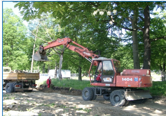
Aufnahme der alten Straßenbefestigung
