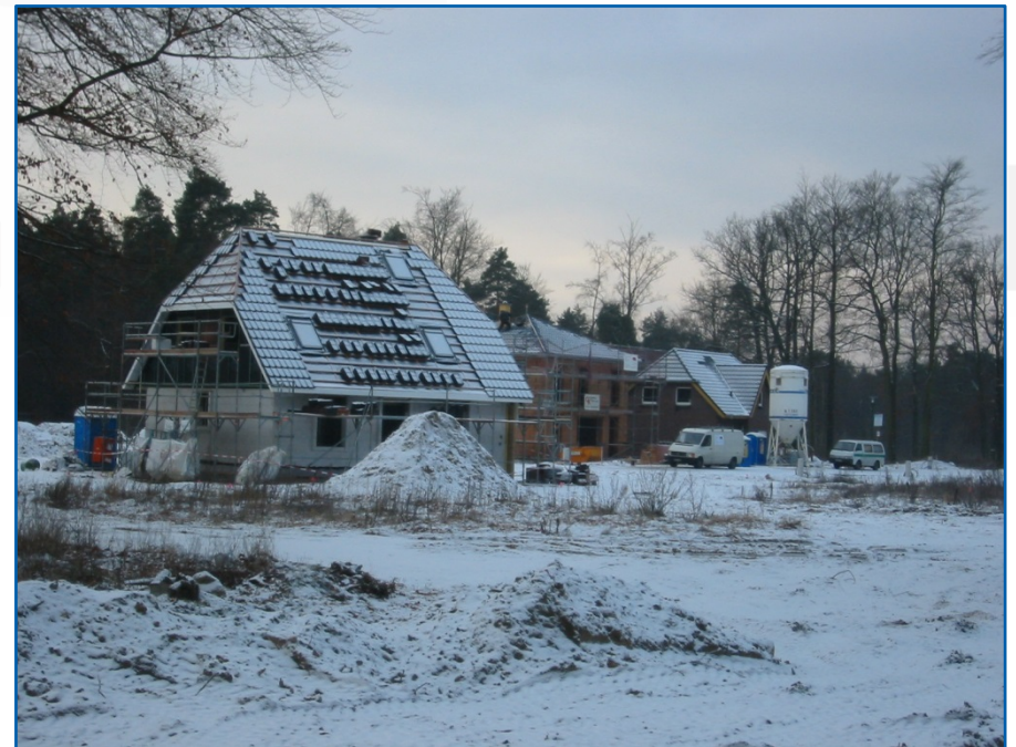
Die ersten Häuser im Bau- Winter 2002
