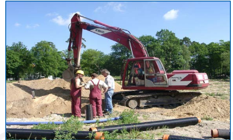
Verlegen der Trink- und Schmutzwasserleitungen
