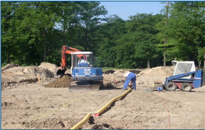
Verlegen der Gasleitungen
