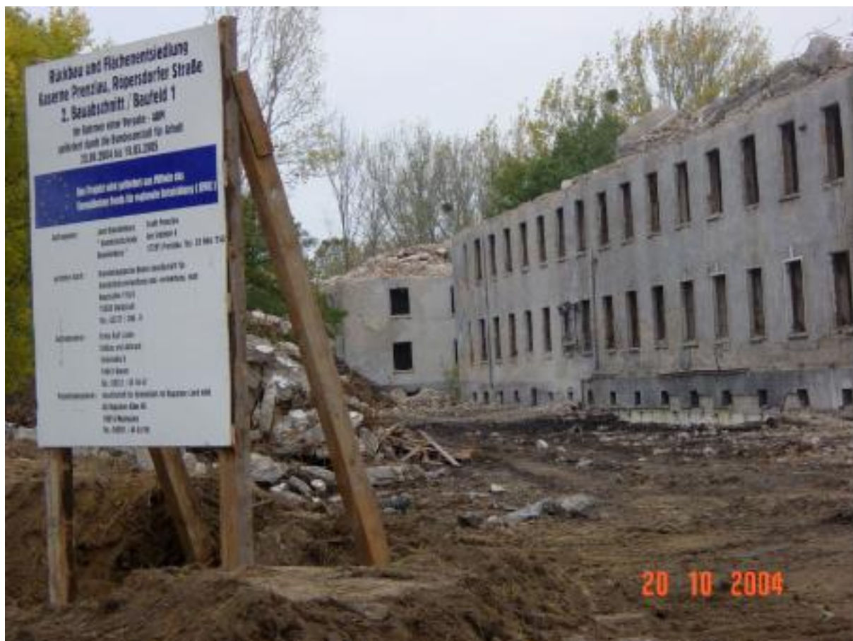
„Rückbau“ in Prenzlau
