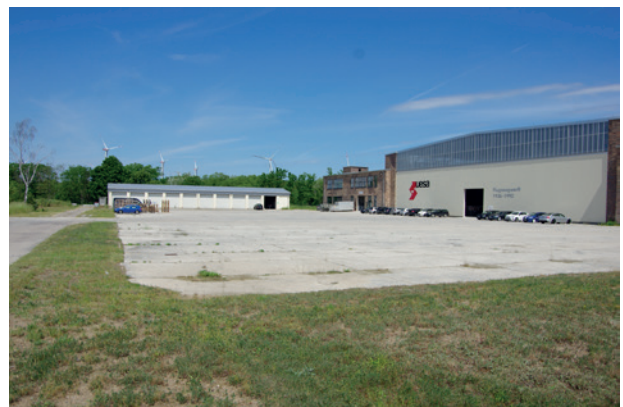
Mittlerweile werden dort moderne Elektro- und Schaltanlagen gebaut. Das familiengeführte Unternehmen UESA ist einer größten Arbeitgeber in der Region Elbe/Elster
