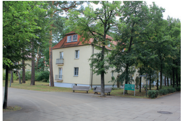
Wohnblock an der Seestraße, 2019 Quelle: Amt Scharmützelsee
