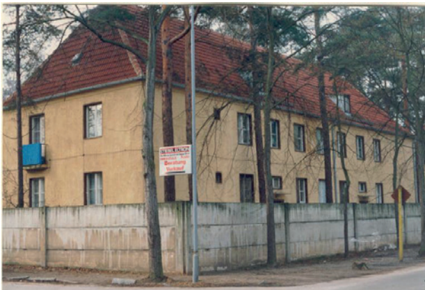
Wohnblock an der Seestraße, 1994 Quelle: Amt Scharmützelsee
