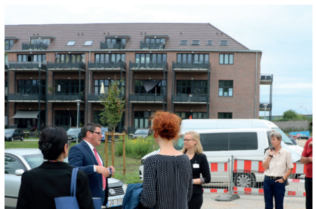
2019 sind die Sanierungsarbeiten am Gebäude fast abgeschlossen
