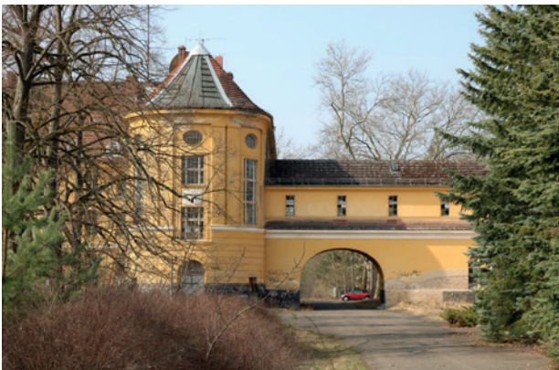
Die ehemalige Militärturnanstalt in Wünsdorf, seit den 1950er Jahren „Haus der Offiziere“ harrt einer Revitalisierung
