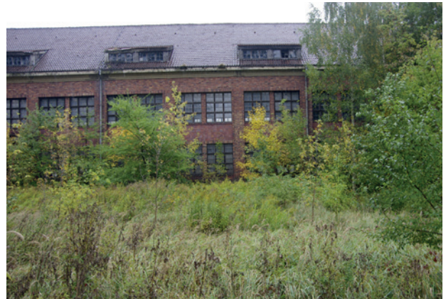
Die ehemalige Heeresbekleidungsanstalt in Bernau vor der Sanierung, 2015
