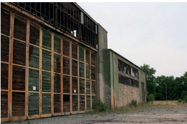
Die Halle der Flugzeugwerft vor der Revitalisierung.
