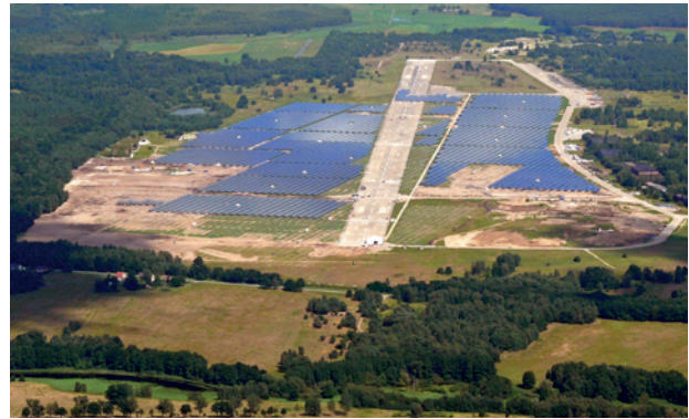
Solarpark, Sommer 2012, Foto: Wolfram Staudinger via Fliegerclub Wittstock / Förderverein zur Erhaltung der historischen Stadtmauer in Wittstock / Dosse e.V.
