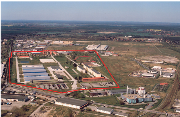
Ehemalige Rolandkaserne in der Stadt Brandenburg an der Havel, 2013 verkauft als zukünftiger Gewerbestandort, Quelle: BlmA
