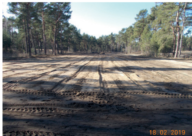
Das Projekt Märkische Heide nach dem Rückbau 2019 Foto: UWEG-Umwelt-, Forschungs- und Dienstleistungsgesellschaft mbH
