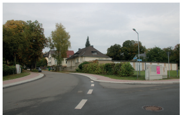
Die Lindenstraße nach der Instandsetzung 2022
