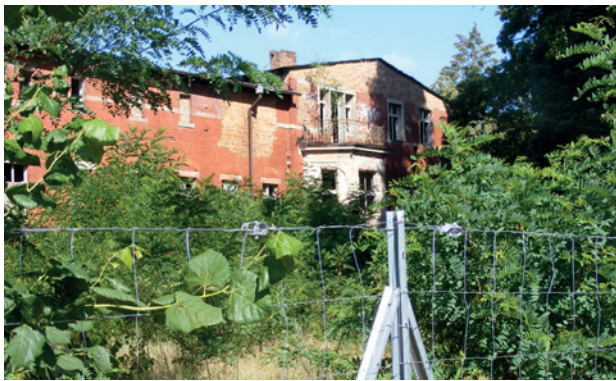
Konversion als Herausforderung, das ehem. Offizierskasino in der Neuen Gartenstraße Foto: BEST PLAN GmbH, Frank Wildschütz
