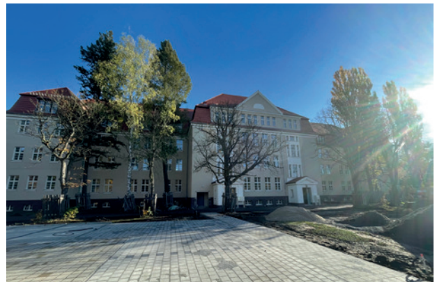
Saniertes Gebäude in Wünsdorf Waldstadt Foto: Julia Hartmann
