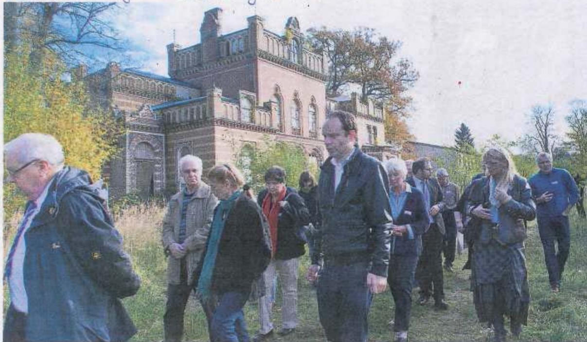
Ein Blick auf das alte Herrenhaus sorgte gestern für Ermüchterung. Es ist so marode, dass niemand das Gebäude betreten darf. FOTOS (2): PETER GEISLER
