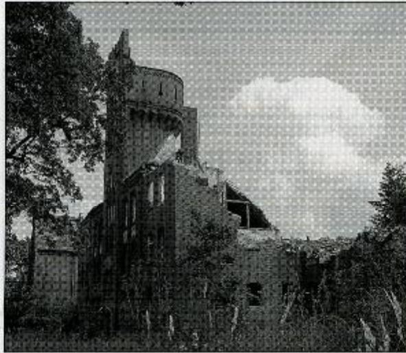
167 Militärbauten in Jüterbog sind Denkmale. Eins davon ist die im Februar 2005 illegal eingerissene Turmkaserne in Jüterbog II.
